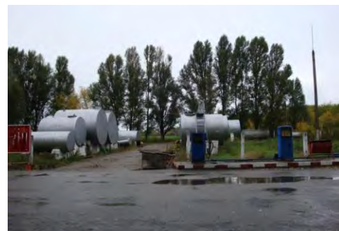
Station de remplissage de gaz
