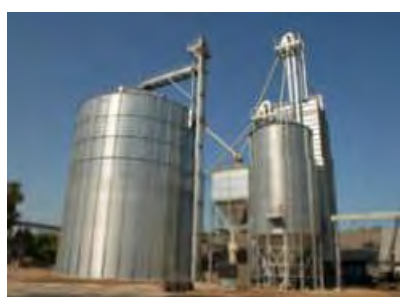
Unité de stockage
